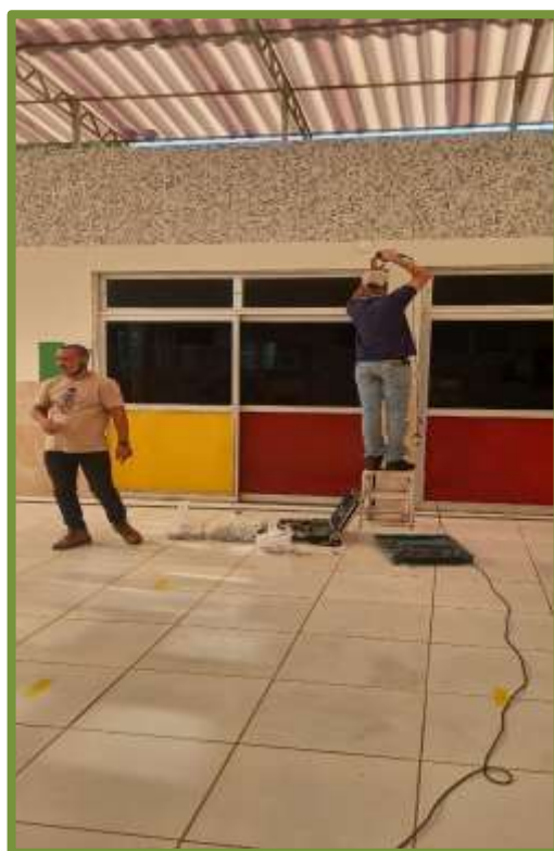
Instalação das câmeras
