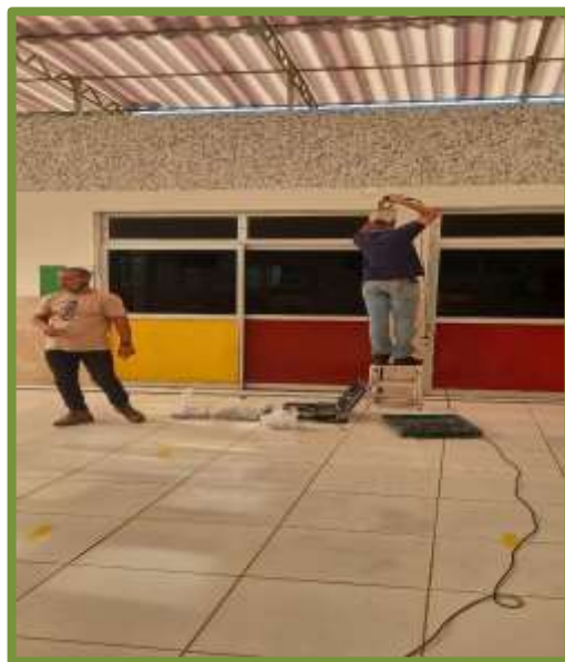
Instalação das câmeras
