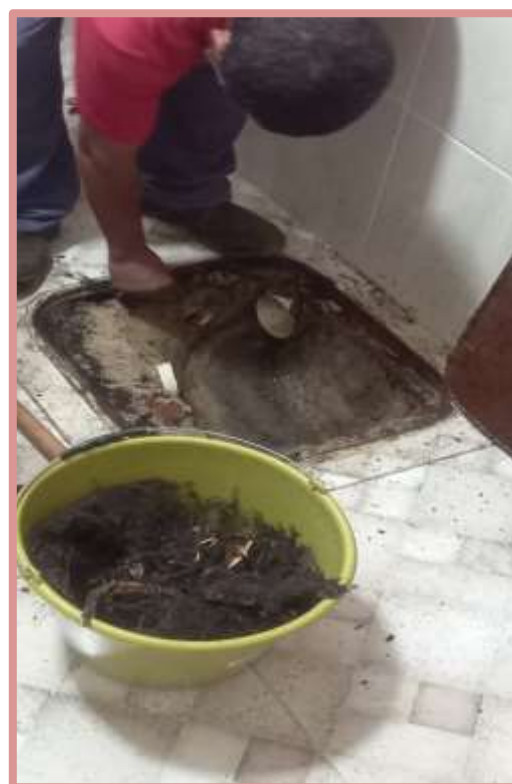
Limpeza da rede de esgoto
