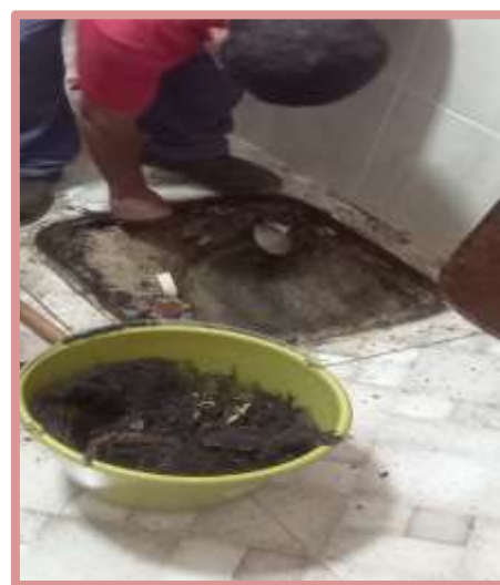
Limpeza da rede de esgoto
